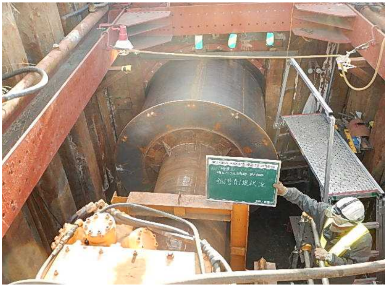
φ 1,700mm鋼管削進状況
