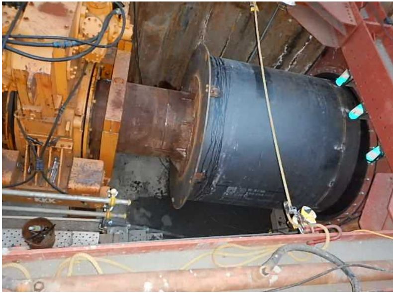
φ 1,700mm鋼管削進状況
